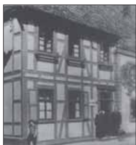
Haus Fischer, Klingelstraße
