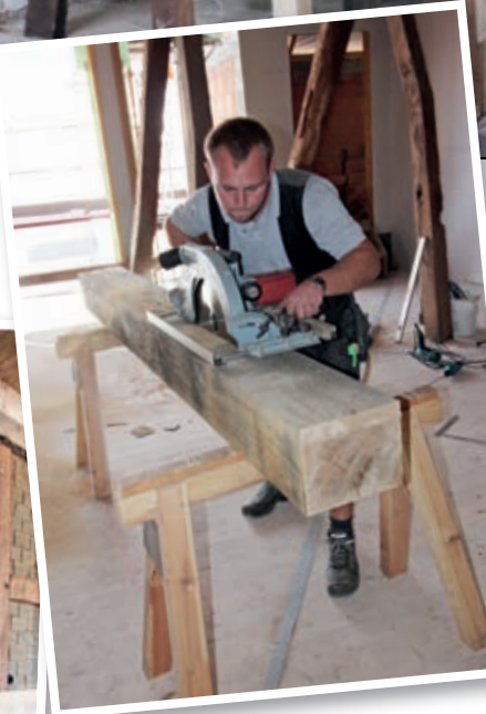
Die Facharbeiter von Temborius & Fretter wissen worauf sie bei der Instandsetzung des Fachwerks achten müssen.
