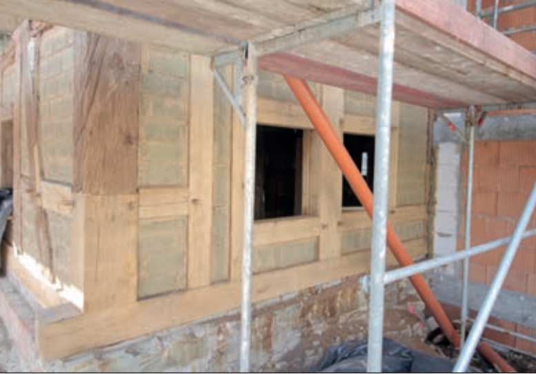
Das ausgebesserte Fachwerk im Detail.
