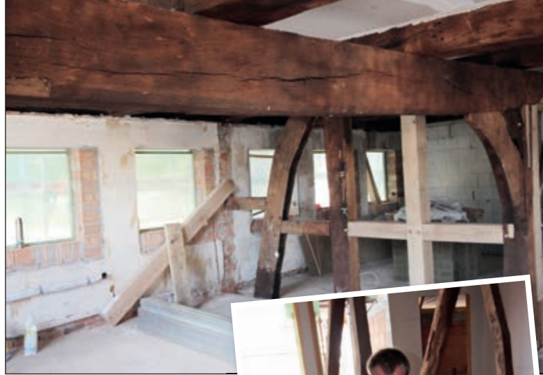
Der älteste Balken des Hauses (oben rechts) bleibt erhalten. Er überspannte einst die Küche.
