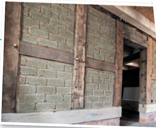
Bei dieser Wand wurde das marode Gebälk komplett durch alte Balken ersetzt.
